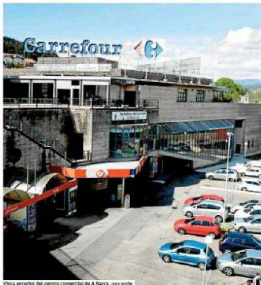
Vista exterior del centro comercial de A Barca. > 11
